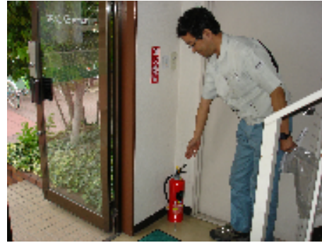
写真 4:消火器位置の確認
